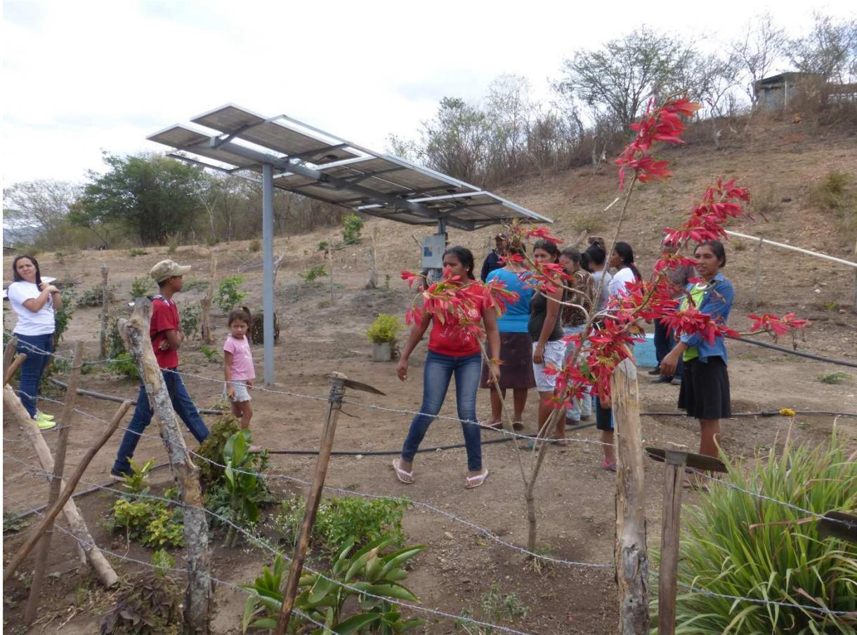
Die Solaranlage pumpt das Wasser für die Beregnung und für das Trinkwasser in einen Tank
